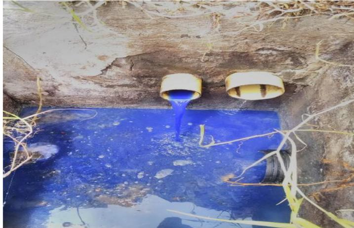
De esta misma manera se identificó la conexión de los apartamentos 101 y 102 los cuales comparten otro colector de 3" pvc-s.
