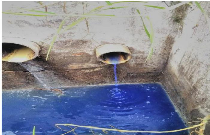
Con la prueba de flujo del primer piso se identificó que el apartamento 103 y 104 comparten el mismo colector de 3" pvc-s.
