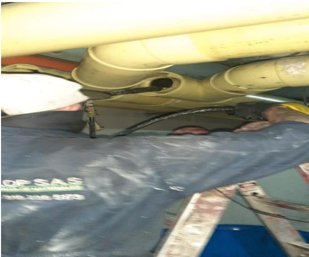
Labor de limpieza con hidroyet 220 PSI Colector enterrado y muy colmatado
