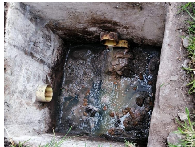
Labor de limpieza con hidroyet 220 PSI Colector enterrado y muy colmatado
