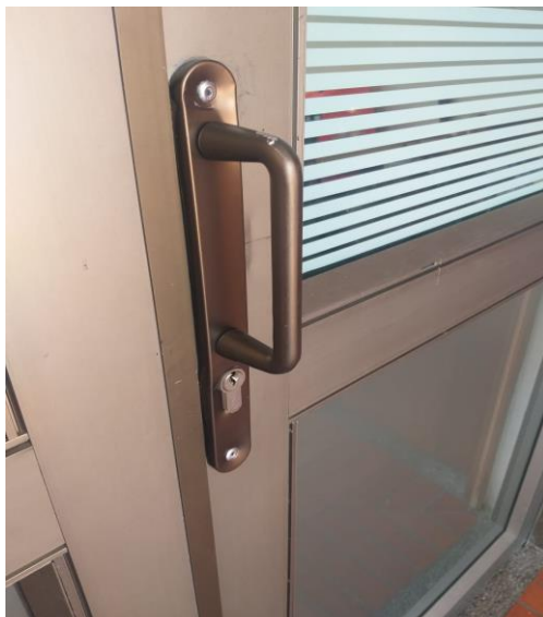
3ER PISO SALÓN COMUNAL
