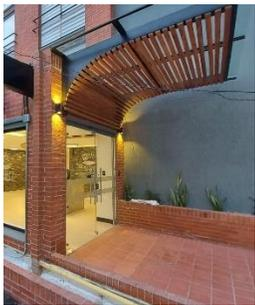
En reemplazo al sistema original de gárgolas se opta ocultar bajantes en fachada con la misma mampostería. Estas bajantes se conectan directamente a los desagües para evitar la colmatación de las jardineras.
