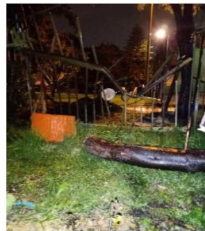
Fotos 7 y 8. Inclinación y peso sobre el muro perimetral que separa del área de parqueaderos
