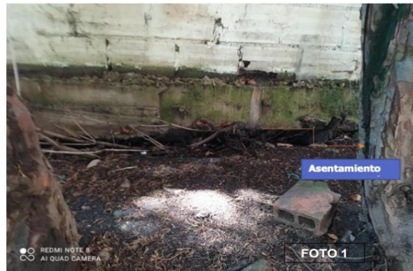
Foto1, 2 y 3. Afectación sobre la cimentación del muro
