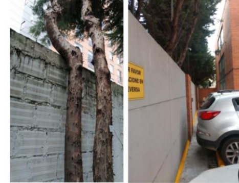
Fotos 7 y 8. Inclinación y peso sobre el muro perimetral que separa del área de parqueaderos
