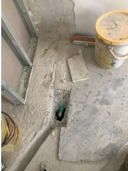
Desmante caja de circuitos
