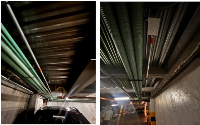
TENDIDO DE INFRAESTRUCTURA 1" 1/2 EMT TRAMO 1 Y 2
