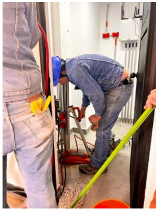
PERFORES EN PLACA Y MUROS
