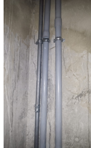
Infraestructura llegada a cuarto de CCTV por sotano 1
